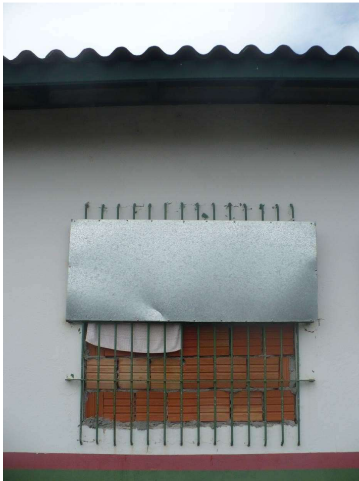
Placa de metal na janela da Ala C
